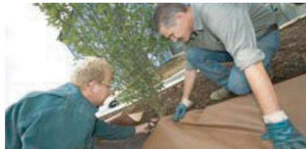
2) Закрепить полотно при помощи крепежных штифтов DuPont. На больших участках, где требуется больше одного полотнища, укладка производится с нахлестом 10 см.
