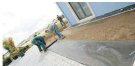
2) Закрепить полотно при помощи крепежных штифтов DuPont Plantex®. На больших участках, где требуется использование более одного полотнища, укладка производится с нахлестом 10 см.
